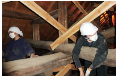
伝統的建築での構造調査
