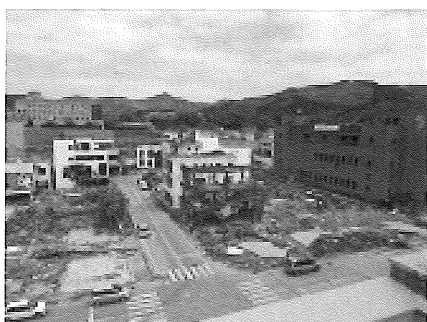
津波による建物の被害(女川町)
