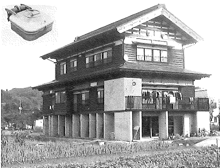
シェルター付き高基礎住宅
