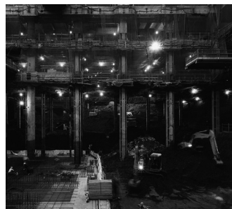
逆打・順打併用の巨大地下躯体
