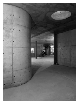
流動的な廊下~オープンスペース
