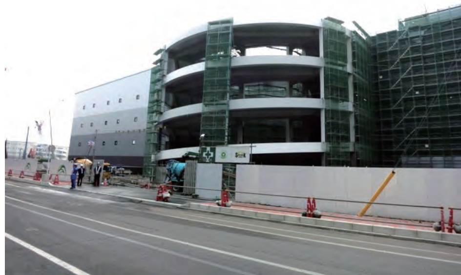
前面道路からの外観
