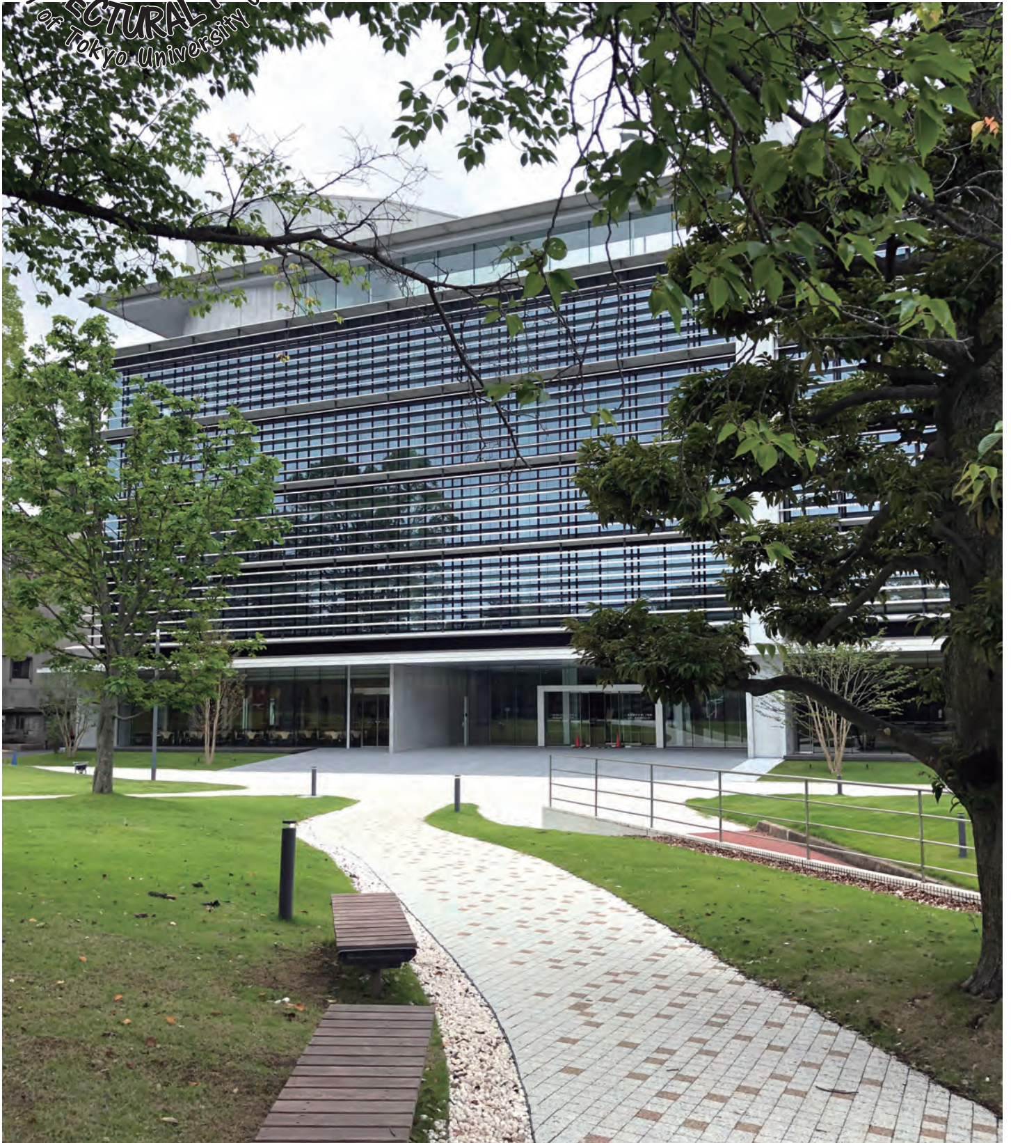
中庭から見る新7号館
