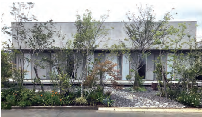
外観 建物正面
