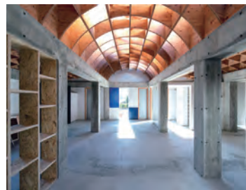
RCの柱梁とLVLの天井格子
